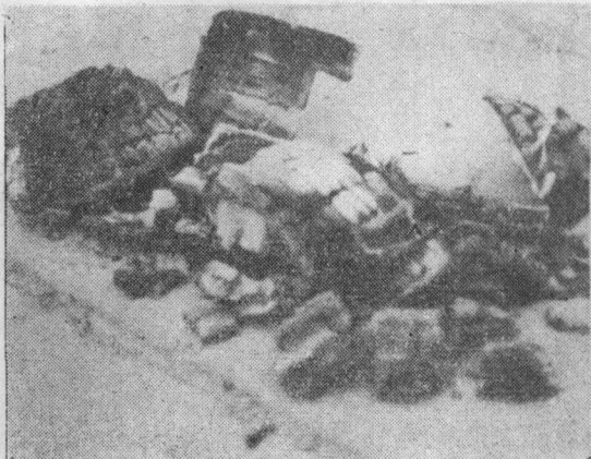
图4 用蒸馏水处理的木板房屋被烧后情况
