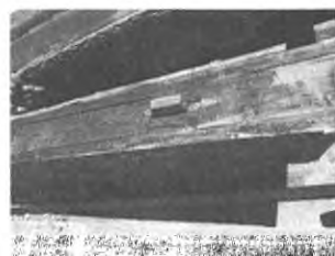
图4 剔除内部腐朽的部分换上新防腐木
