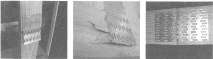
a 齿拔出破坏 b 木材撕裂破坏 c 齿板断裂破坏
