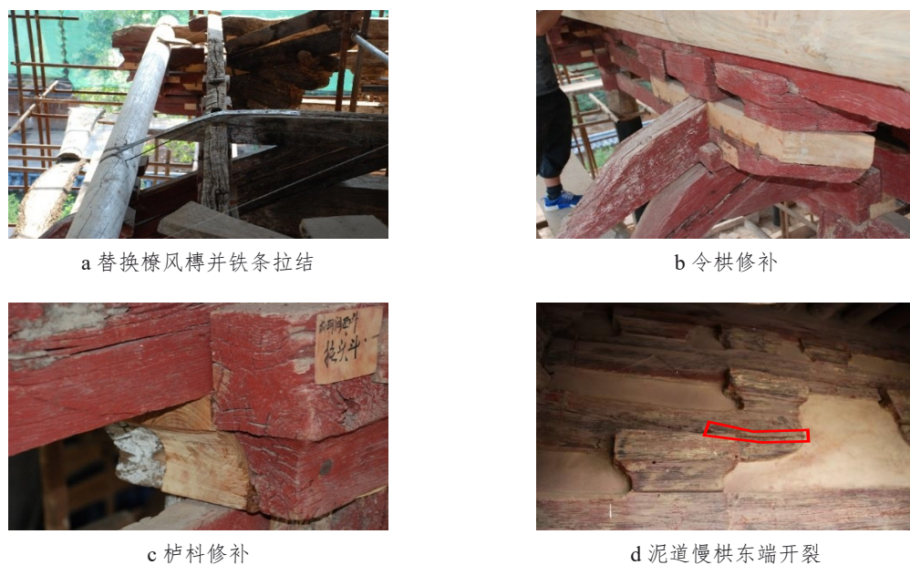
图10 前檐心间西平柱上部构造变化
