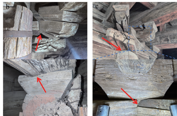
a 嵌压示意简图;b 严重嵌压示例;c 内槽柱头-普拍枋-枂斗节点严重嵌压示例。
